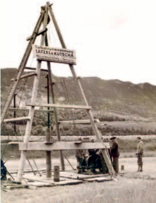
stellen. In den Jahren 1951/52 wurde dem entsprechend in der Nähe der Auflegerkapelle ein Trinkwasserbrunnen niedergebracht, der rund 40 Jahre in Betrieb sein sollte. Während dieser Zeit wurde Trink- und Gebrauchswasser überwiegend dem Grundwasser entnommen.
